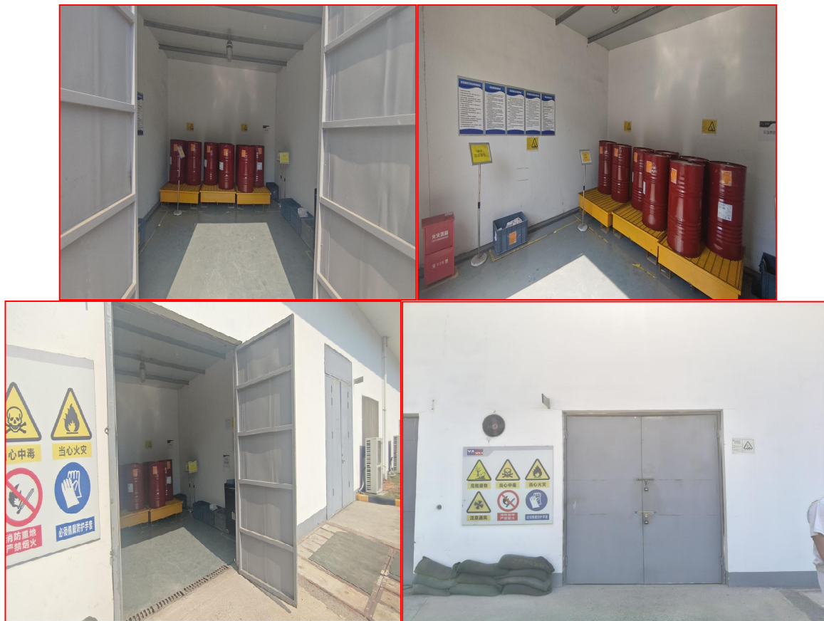
图 3-3 危废暂存间建设情况
