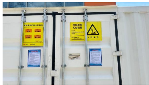
危废暂存间（外部）
